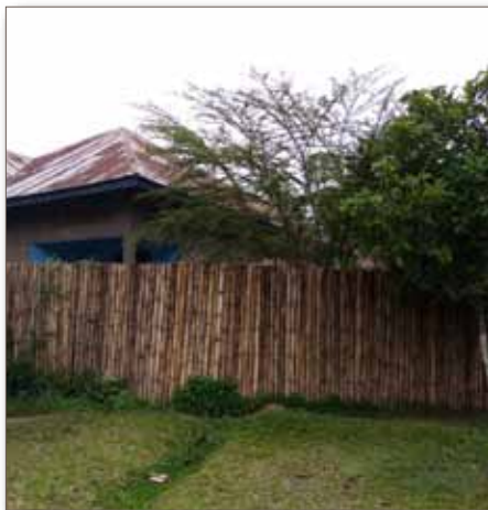
Zur Absicherung des AFPD Geländes wurde ein Zaun errichtet.
