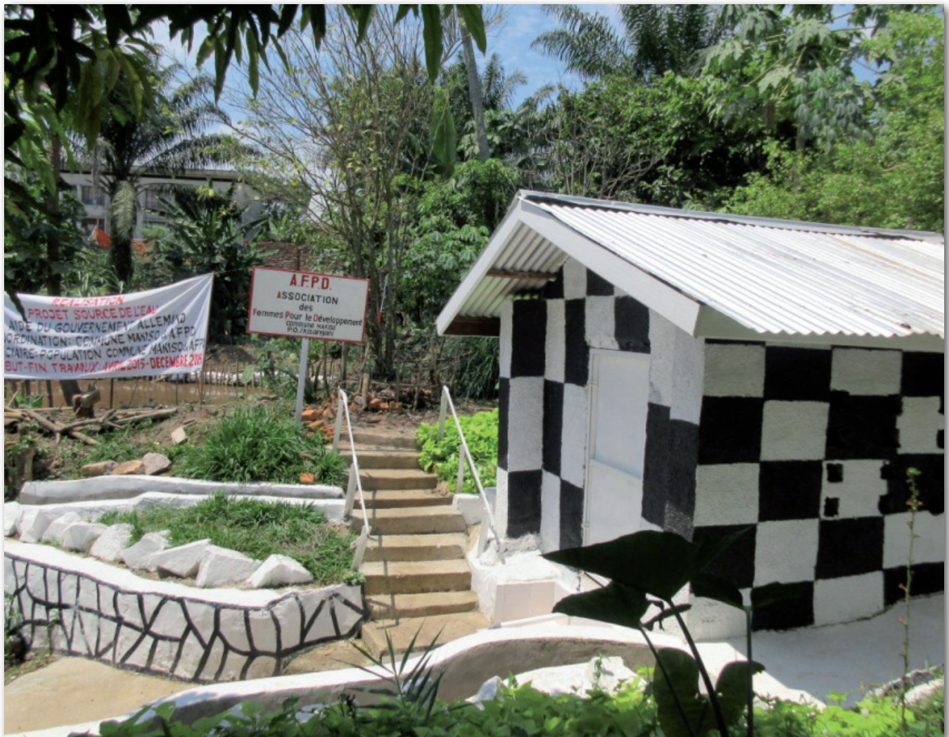
Ein Haus für die Quelle: Hinter der Tür befindet sich der Zugang zur Trinkwasserquelle. Nur ausgebildetes Personal hat hier Zugang.
