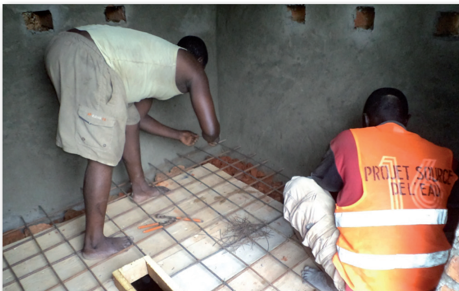
Auch der Innenraum wird betoniert, hier verlegen die Arbeiter gerade die Eisenarmierung. In dem Schacht befindet sich die Pumpe, die das Wasser an die Oberfläche befördert.
