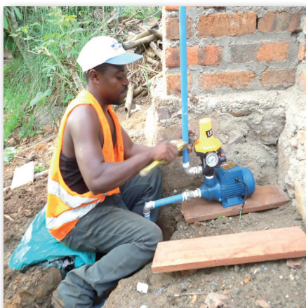
Der Arbeiter installiert die Pumpe, die das Wasser vom Trinkwasserhäuschen zu den Reservoirs befördert.
