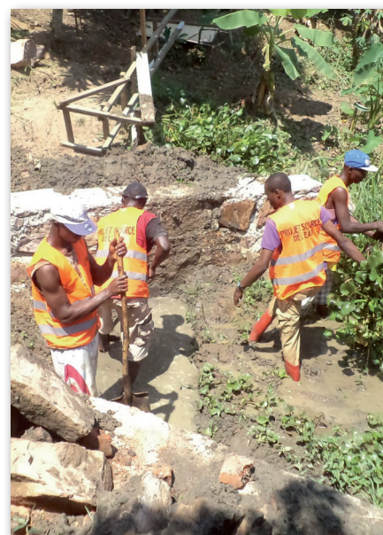
Ein stabiles Fundament und Mauern schützen die Quelle vor Überschwemmungsschäden und Verunreinigung.
