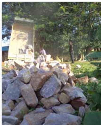
Für die Befestigung des Untergrundes werden massive Steinblöcke benötigt.
