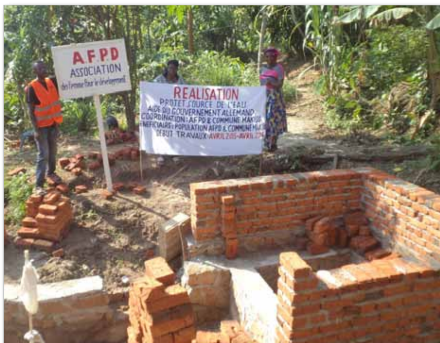
Das Plakat an der Baustelle informiert über die Geldgeber (Bundesministerium für wirtschaftliche Zusammenarbeit und Entwicklung) und die ausführenden Organisationen bzw. Träger vor Ort (AFPD, Commune Makiso).
