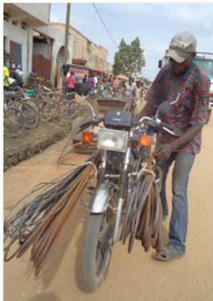
Vom Markt zur Baustelle: Ein Arbeiter transportiert recht abenteuerlich Moniereisen zur Baustelle.
