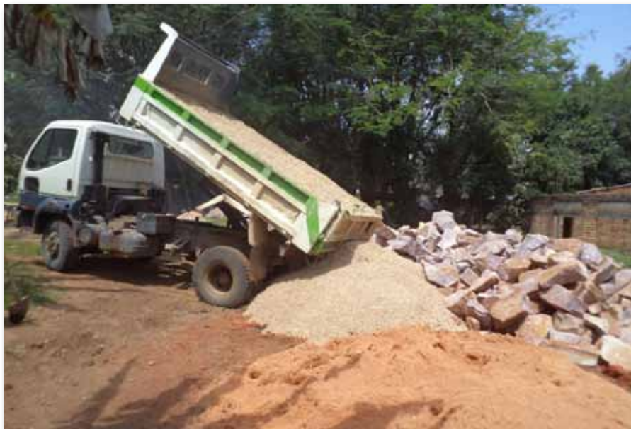
Der LKW bringt Sand und Steine für die Baumaßnahme aus dem örtlichen Kieswerk.
