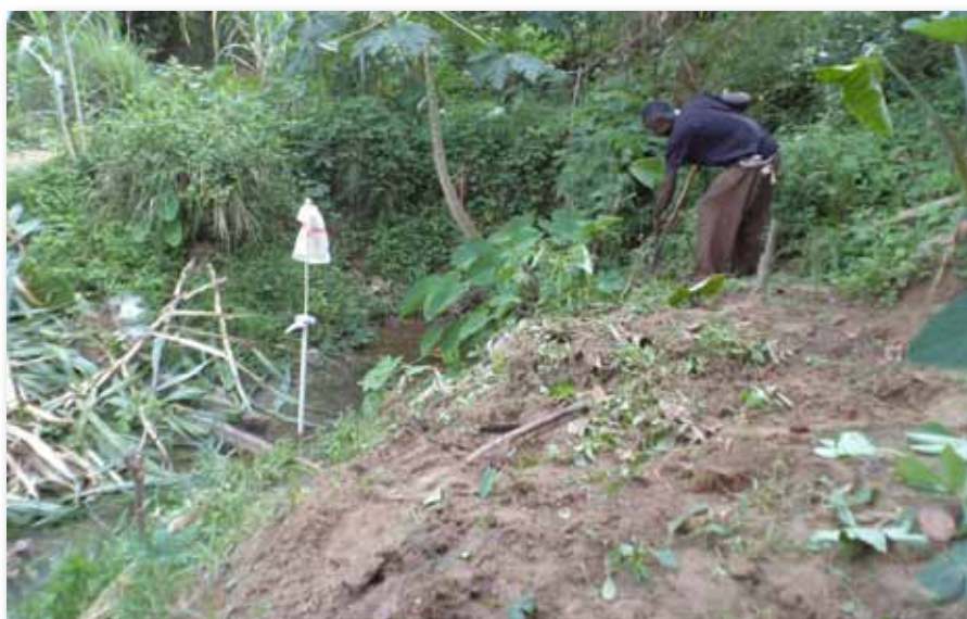
Hier legt ein Bauarbeiter das Terrain für die folgenden Bauarbeiten frei.
