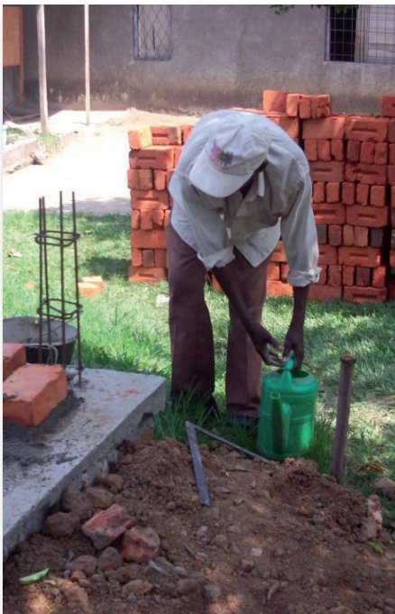
Ein Helfer setzt Eisenarmierungen ins Fundament.
