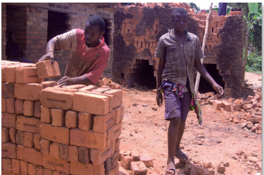
Die Lehmziegel werden im Ofen auf dem Gelände gebrannt.
