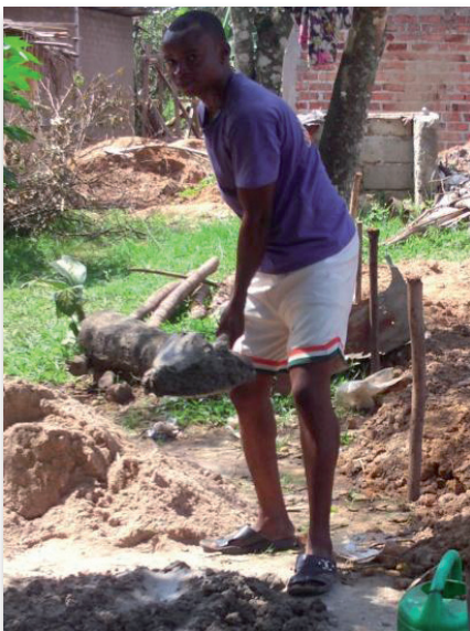
Alle packen mit an, damit das Gebäude bald fertig wird.
