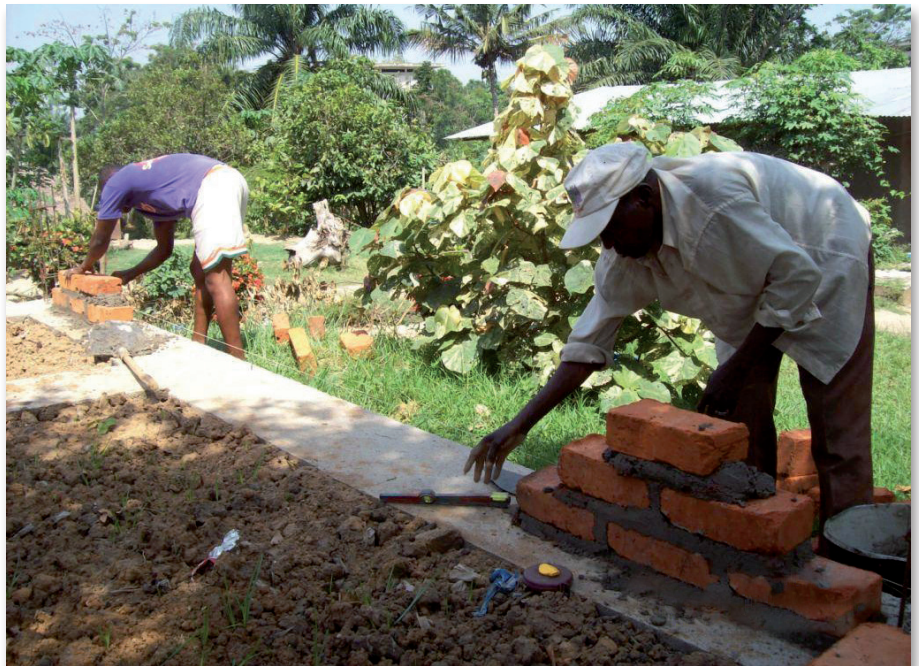
Das Fundament ist gesetzt, die Mauern für das neue Gebäude wachsen.
