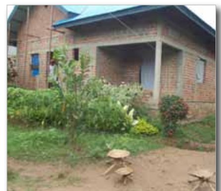
So sah das Gebäude noch vor einem halben Jahr aus.
