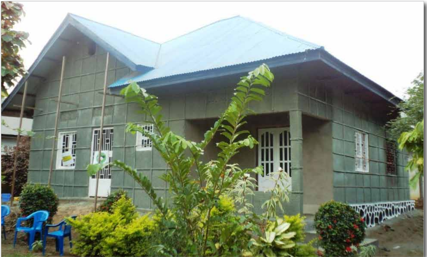
Das neue Gebäude hat neun Zimmer. Massiv gemauerte Wände, ein dichtes Dach, moderne Fenster und Türen schützen vor Hitze und Regen. Es fehlt noch der Außenputz, Moskitonetze vor den Fenstern sowie einiges Mobiliar.
